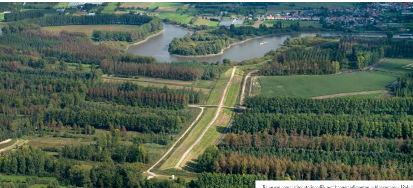
Bouw van compartimeteringsdijk met baggersedimenten in Vlassenbroek (België)
