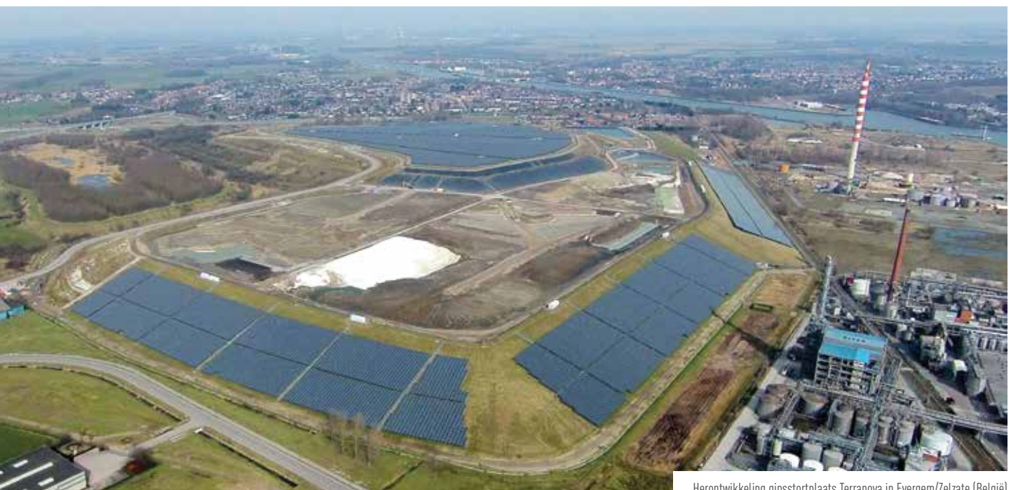
Herontwikkeling gipsstortplaats TerraNova in Evergem/Zelzate (België)
