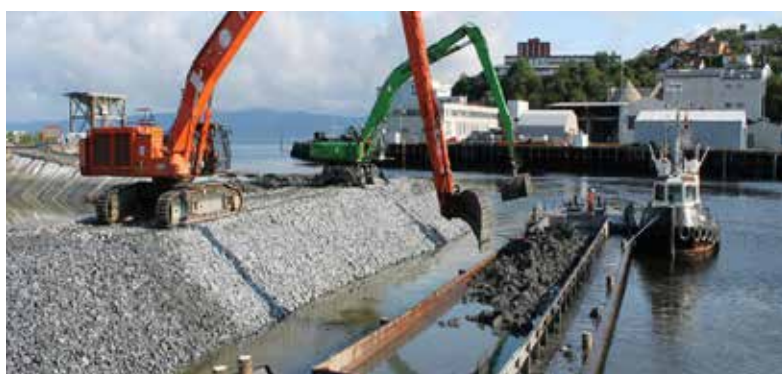
Sanering van het havenbassin en havenuitbreiding met baggersedimenten in Trondheim (Noorwegen)
