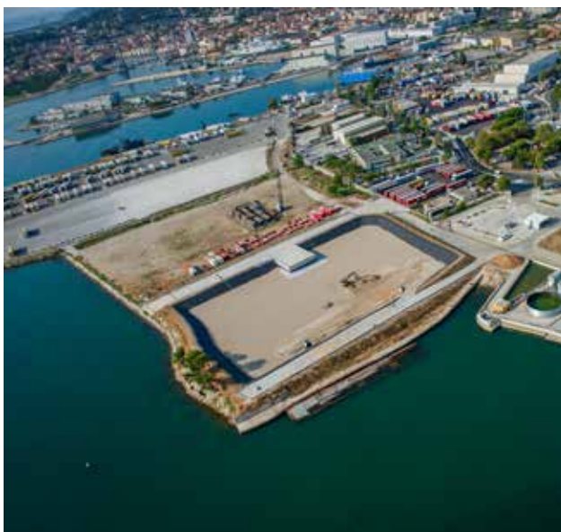
Grond- en sedimentverwerkingscentrum CPEM in La Seyne-sur-Mer (Frankrijk)
