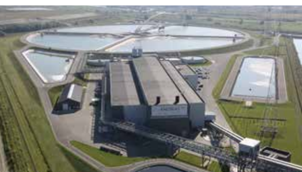
Verwerking van baggerspecie uit de haven van Antwerpen in de AMORAS-installatie (België)
