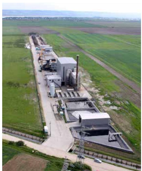
Ontwerp, bouw en exploitatie van afvalverwerkingsinstallatie in Pitesti (Roemenië)
