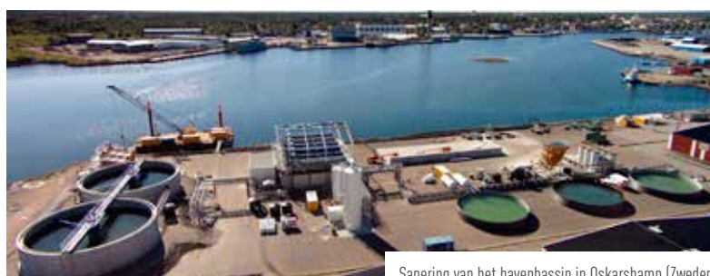
Sanering van het havenbassin in Oskarshamn (Zweden)
