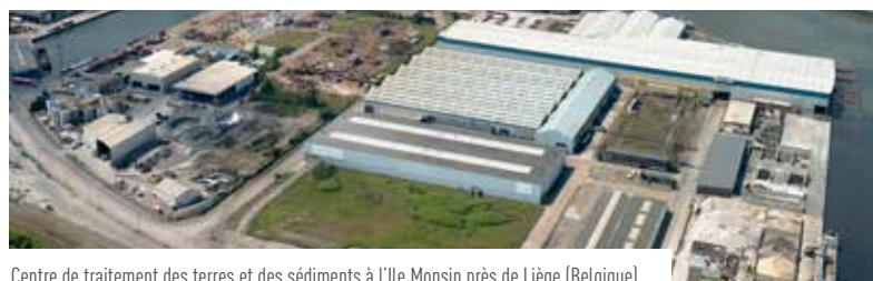
Centre de traitement des terres et des sédiments à l'île Monsin près de Liège (Belgique)
