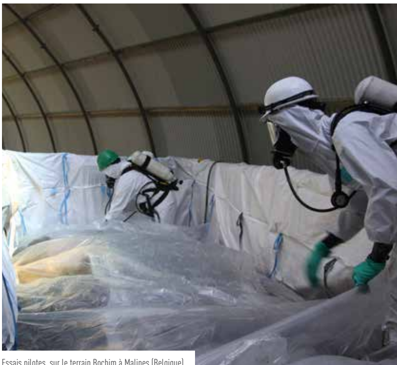
Essais pilotes sur le terrain Bochim à Malines (Belgique)
