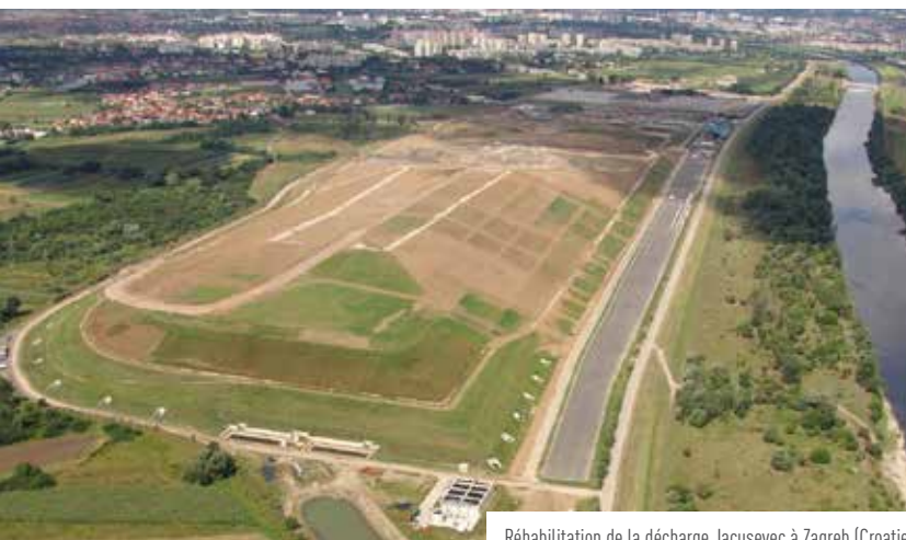
Réhabilitation de la décharge Jacusevec à Zagreb (Croatie)
