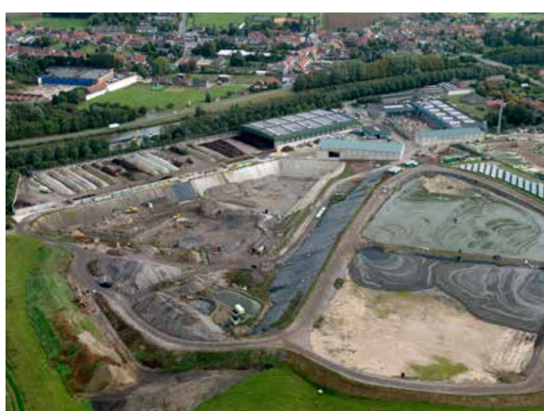
Centrul de tratare a nămolului situat lângă canalul Bossuit-Kortrijk în Moen (Belgia)
