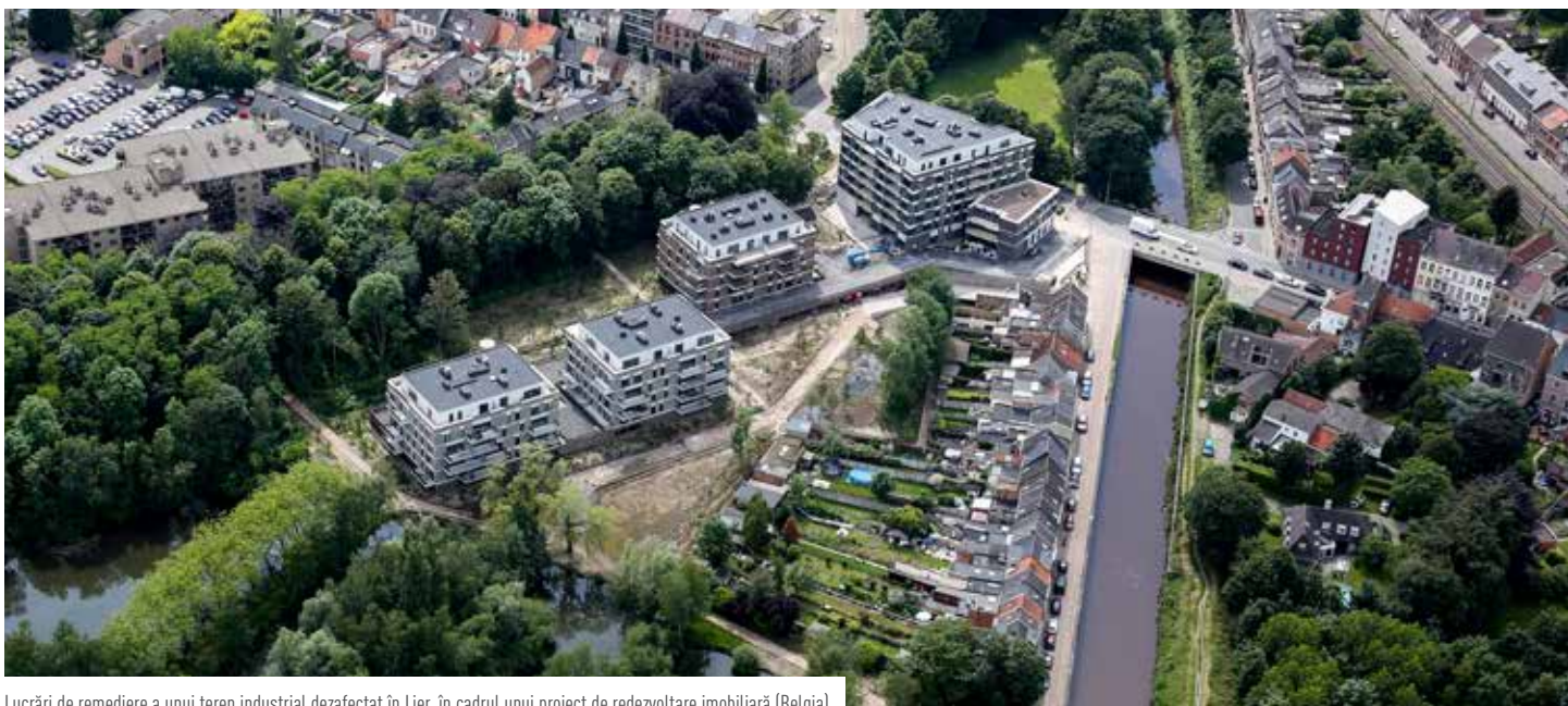
Lucrări de remediere a unui teren industrial dezafectat în Liege, în cadrul unui proiect de redevoltare imobiliară (Belgia)
