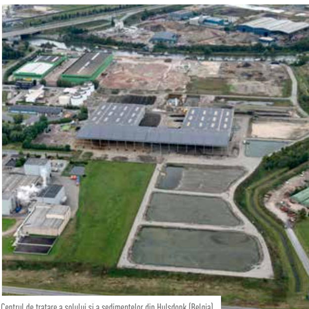
Centrul de tratare a solului și a sedimentelor din Hulsdonk (Belgia)
