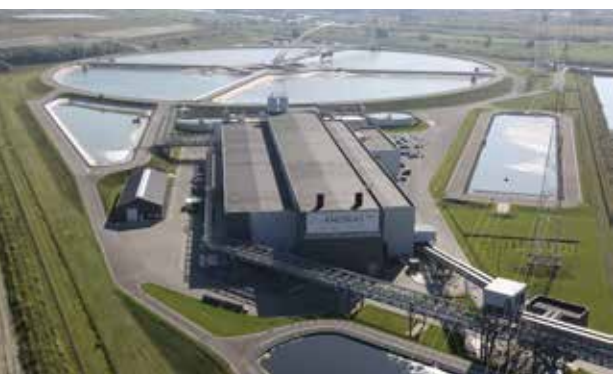
Prelucrarea nămolului de dragare din portul Anvers în instalația AMORAS (Belgia)
