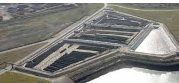
Valorificarea sedimentelor de dragare poluate într-un dig în Dunkerque (Franța)
