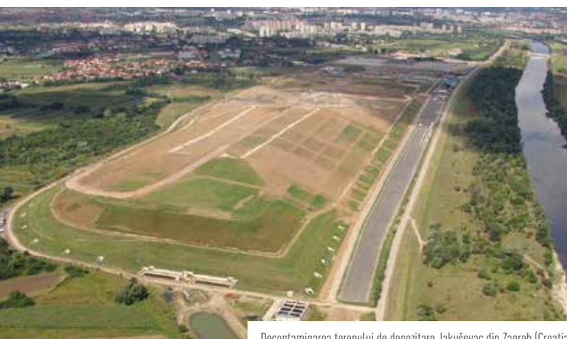
Decontaminarea terenului de depozitare Jakuševac din Zagreb (Croatia)
