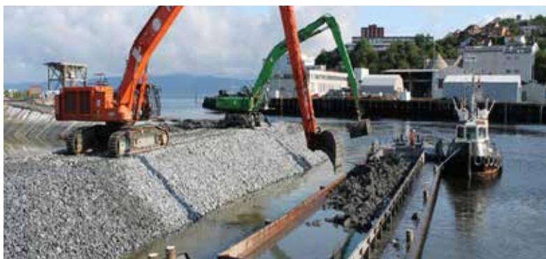
Reabilitarea bazinului portuar și extinderea portului cu sedimente de dragare în Trondheim (Norvegia)
