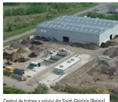
Centrul de tratare a solului din Saint-Ghislain (Belgia)
